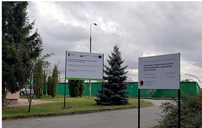
Fot. 1. Oczyszczalnia ścieków w Krynicy Morskiej
