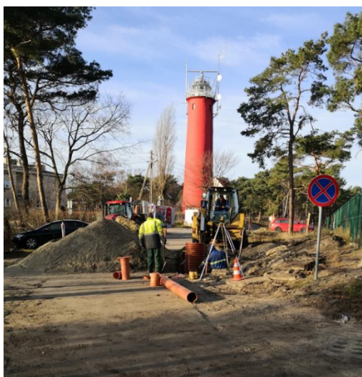
Fot. 8. Rozbudowa kanalizacji sanitarnej w ulicy Żołnierzy
