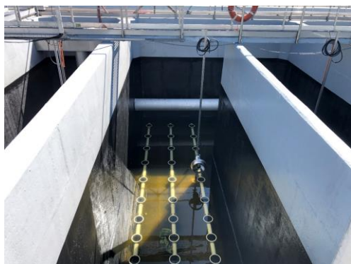
Fot.2. Modernizacja reaktorów biologicznych
